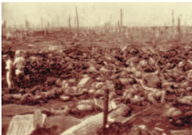
関東地震 本所被服廠跡(写真提供:国立科学博物館)
