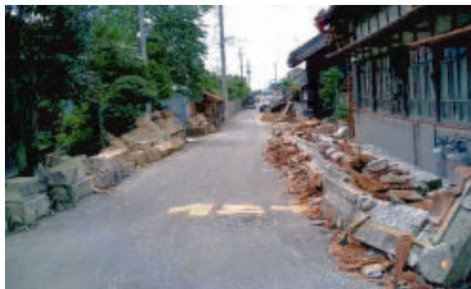
被災現場(倒壊ブロック塀)
